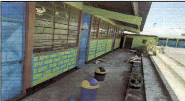
Foto 3: inicio de la pintada de paredes
