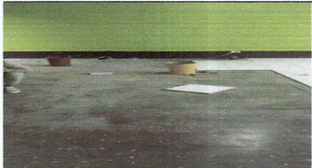
Foto 4: Trabajos de cambio de piso cerámico en las aulas
