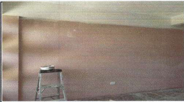
Foto1: raspado y limpieza de paredes
